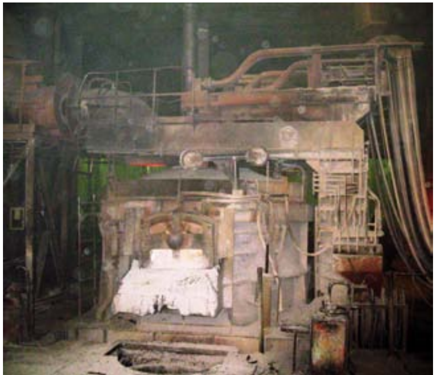
Bild 1: Lichtbogenofen 1 vor der Instandsetzung.
